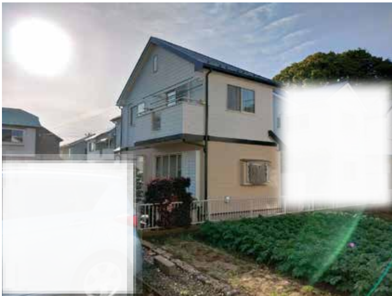
【工事種目】塗装工事 【施工内容1】全体 【施工内容2】施工完了
