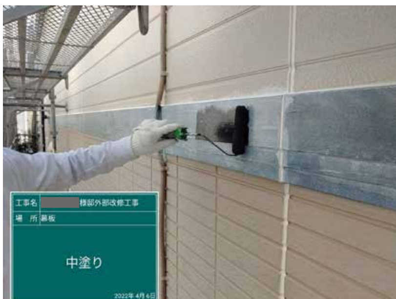
【工事種目】塗装工事 【施工内容1】幕板 【施工内容2】中塗り 【メモ1】ファインウレタンU100 (N-20)
