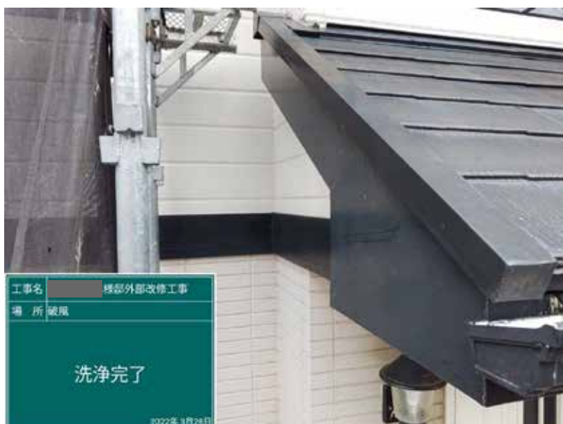
【工事種目】高圧水洗浄 【施工内容1】破風 【施工内容2】洗淨完了
