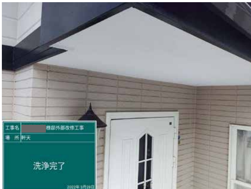
【工事種目】高圧水洗浄 【施工内容1】軒天 【施工内容2】洗浄完了
