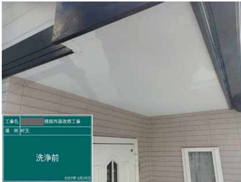
【工事種目】高圧水洗浄 【施工内容1】軒天 【施工内容2】洗浄前
