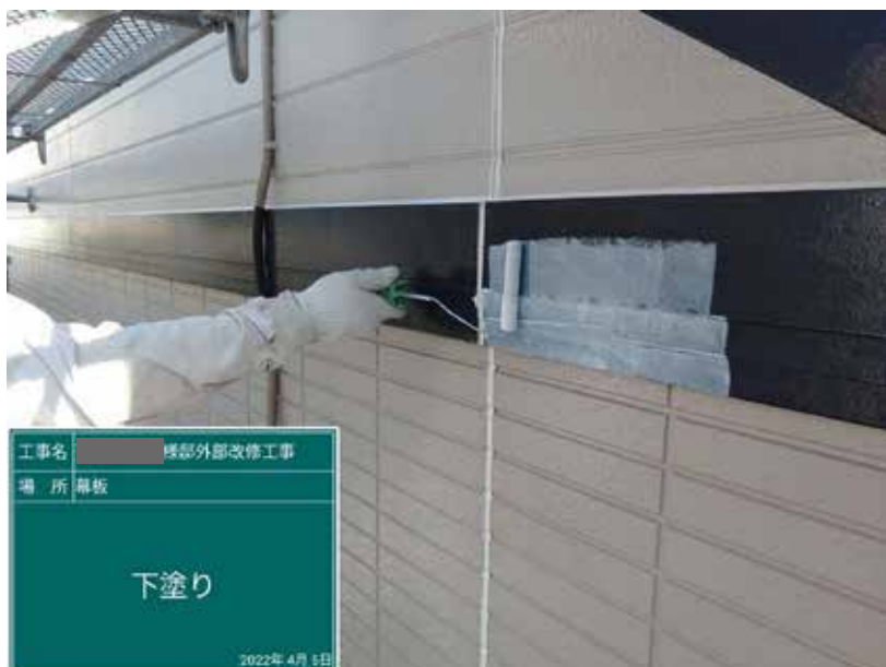
【工事種目】塗装工事 【施工内容1】幕板 【施工内容2】下塗り 【メモ1】水性ミラクシーラーエコ
