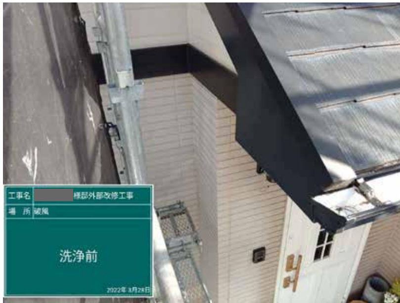
【工事種目】高圧水洗浄 【施工内容1】破風 【施工内容2】洗淨前
