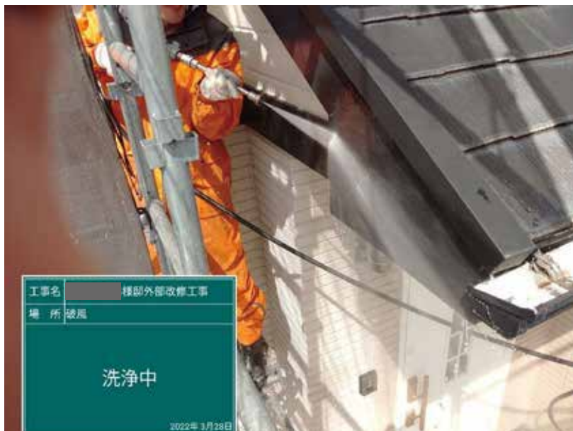
【工事種目】高圧水洗浄 【施工内容1】破風 【施工内容2】洗淨中
