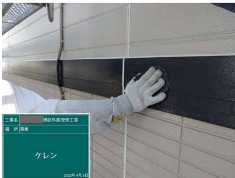
【工事種目】塗装工事 【施工内容1】幕板 【施工内容2】ケレン
