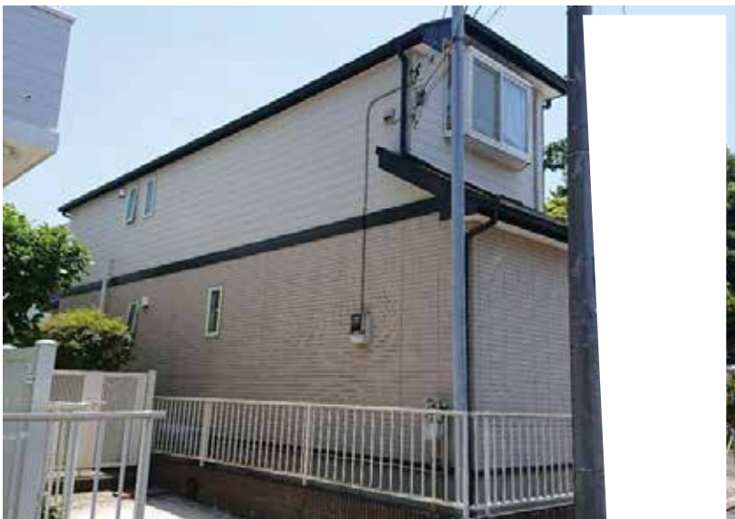
【工事種目】塗装工事 【施工内容1】全体 【施工内容2】施工前
