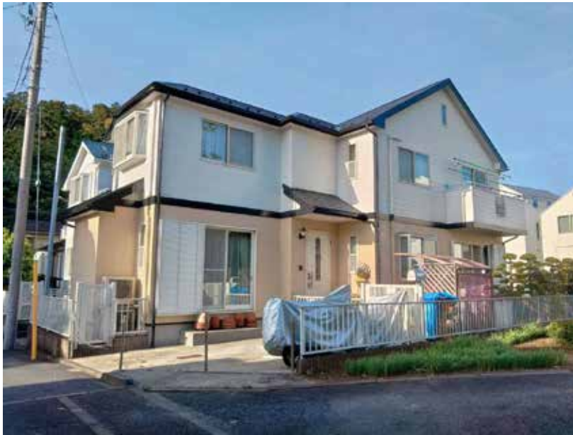
【工事種目】塗装工事 【施工内容1】全体 【施工内容2】施工完了
