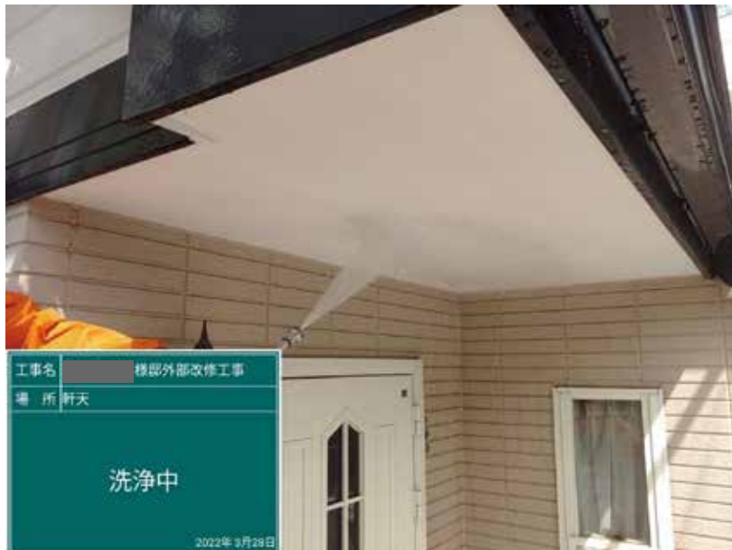
【工事種目】高圧水洗浄 【施工内容1】軒天 【施工内容2】洗浄中
